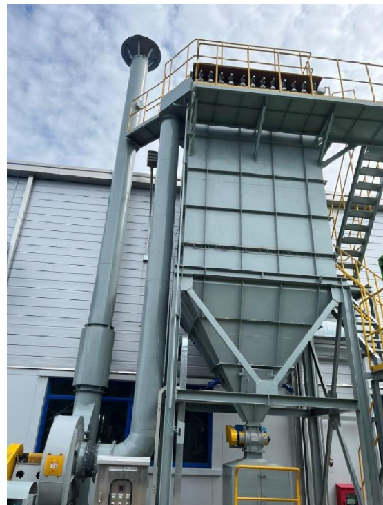
Hình 3. 10. Hệ thống xử lý khí thải tại Công ty
