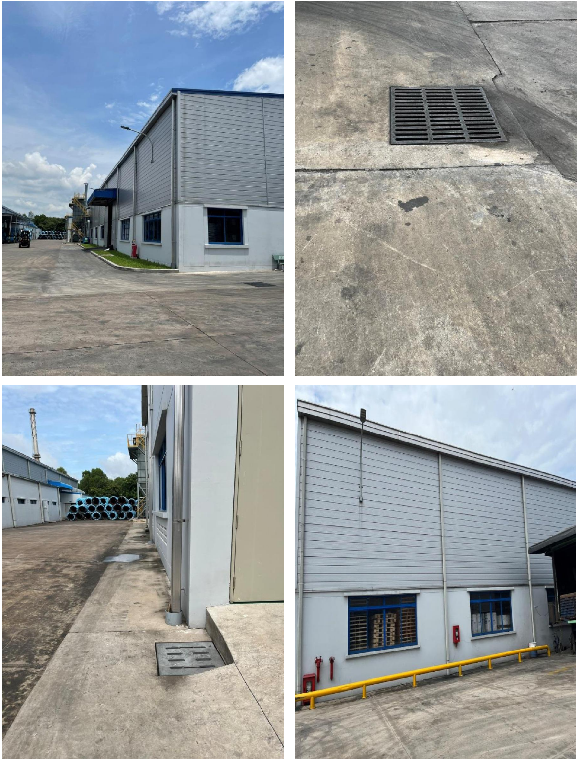
Hình 3. 2. Hình ảnh hệ thống thu gom nước mưa tại cơ sở
